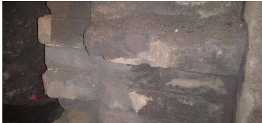
炉衬情况（切割后的东南出铁口）
