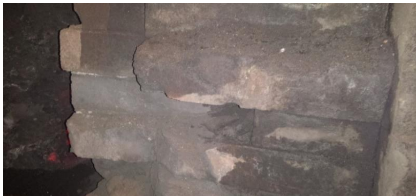
Фотография показывает состояние футеровки контура лётки справа (юго-восточная сторона).
